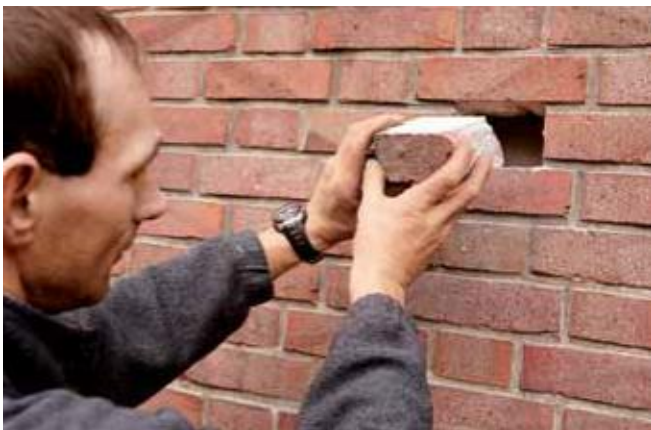
Entfernen eines Steins bei Verwendung einer Großdüse
