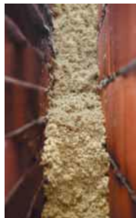
Ansetzen und Abdichten der Großdüse
