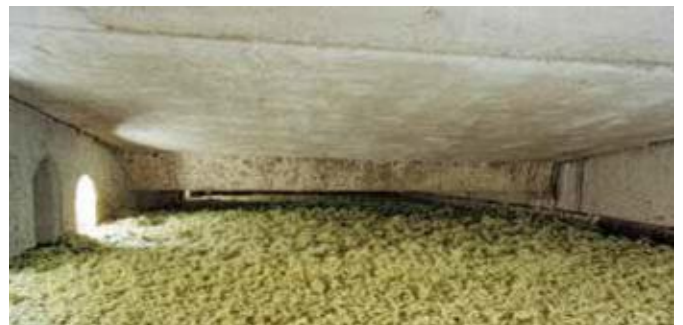
Belüftetes Flachdach, mit Fillrock RG gedämmt
