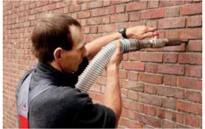
Einsetzen der Kleindüse in die Bohrung in der Kreuzfuge
