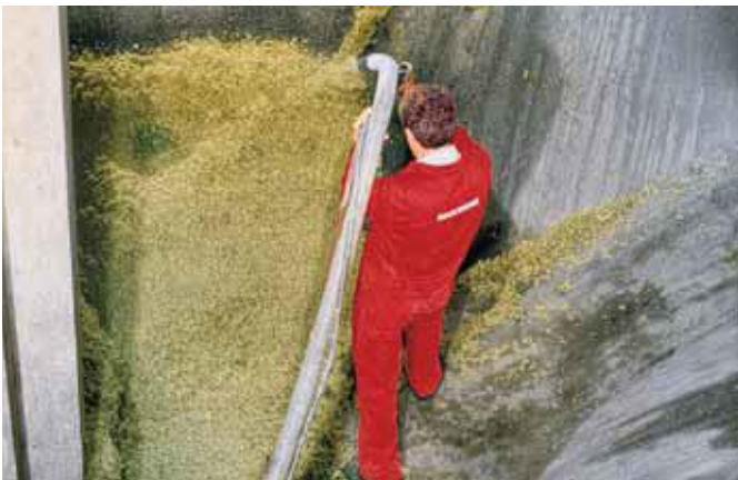
Gleichmäßiges Aufbringen der fugenlosen Dämmschicht
