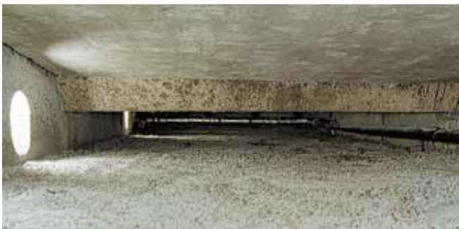
Belüftetes Flachdach vor dem Einbringen von Fillrock RG
