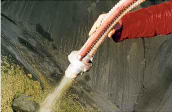
Die Dämmschicht ist auch bei gewölbten Untergründen lagestabil
