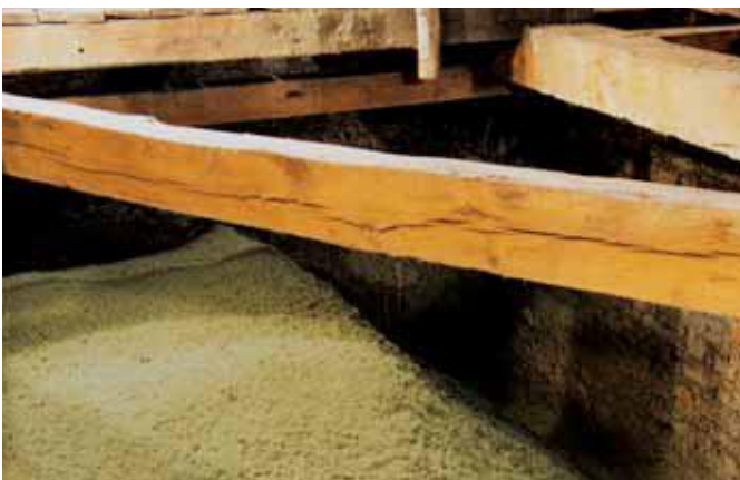
Abrutschsicher aufgebaute Dämmschicht Fillrock RG
