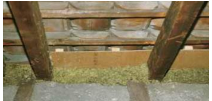
Dachschräge, mit Fillrock RG gedämmt (mit Hinterlüftung)
