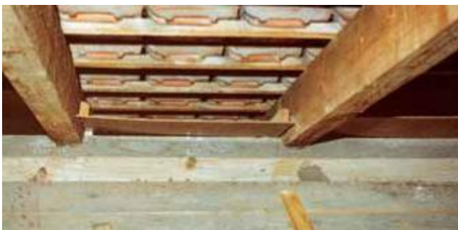
Dachschräge, vorbereitet für das Einblasdämmsystem
