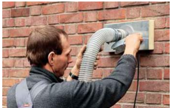
Ansetzen und Abdichten der Großdüse
