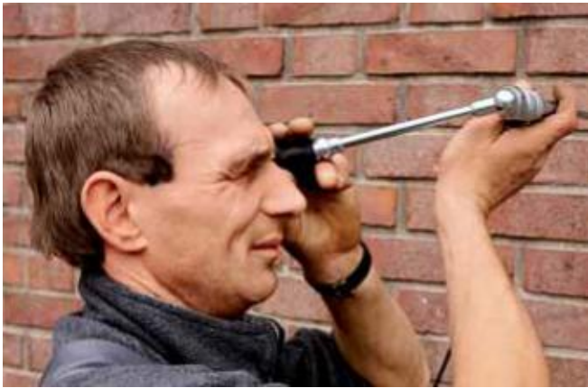
Kontrolle der Luftschicht mit dem Endoskop
