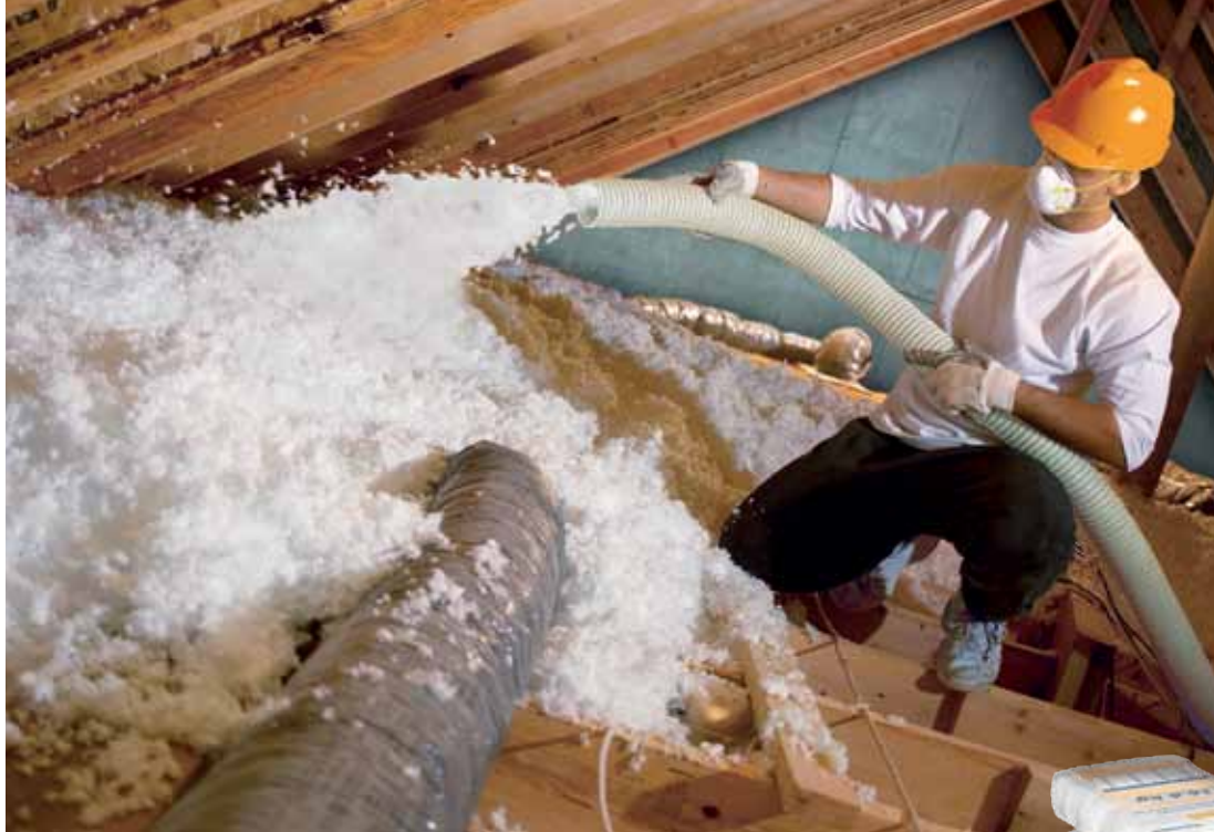
Knauf Insulation Supafil Loft für die Aufblasdämmung in Flachdächern und Obersten Geschossdecken.
